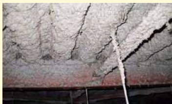
事務室の天井裏
